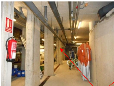
SEÑALIZACION ERRONEA, INDICA SALIDA Y ESTA EN COLUMNA
